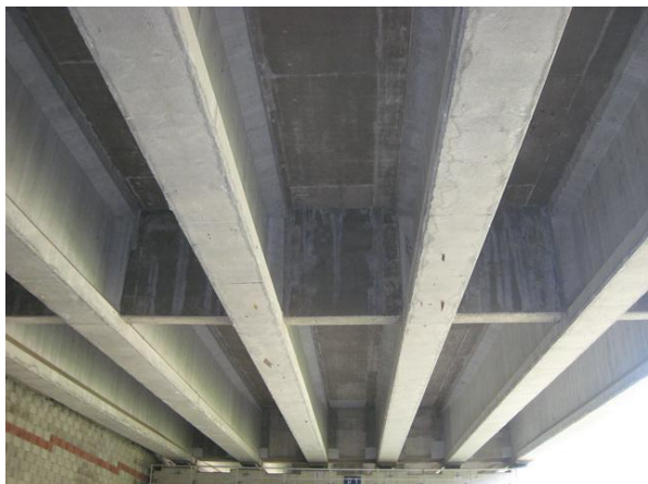
거더 및 바닥판하면 전경
